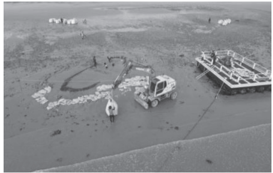
파도막이 및 바지선 설치
